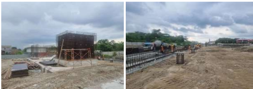
Gambar 3. 8 Dokumentasi Progress Kegiatan Pembangunan JLKAMB
