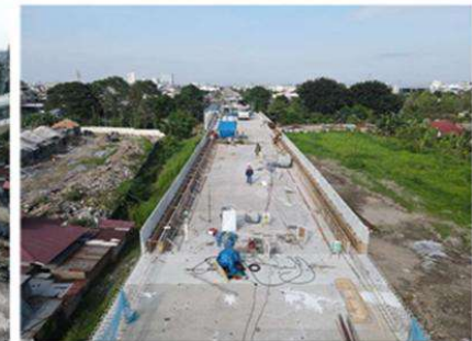
Pemasangan Parapet Span P3-P4
