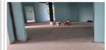
Pekerjaan Arsitektur Stasiun Helvetia
