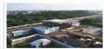
Pekerjaan Bangunan Stasiun Helvetia
