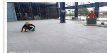
Pekerjaan Arsitektur Stasiun Helvetia
