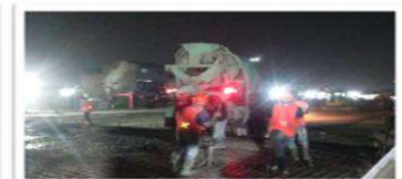
Pekerjaan Landscape Stasiun Helvetia
