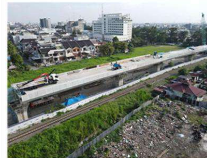
Pekerjaan Parapet P4-P5
