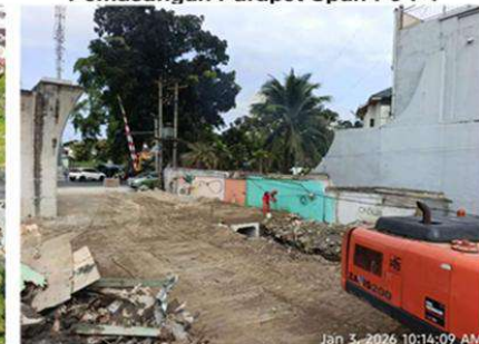
Pekerjaan Timbunan Dan Pemasatan P9bj-P0
