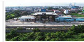
Pekerjaan Bangunan Stasiun Helvetia
