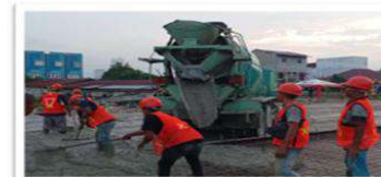
Pekerjaan Landscape Stasiun Helvetia
